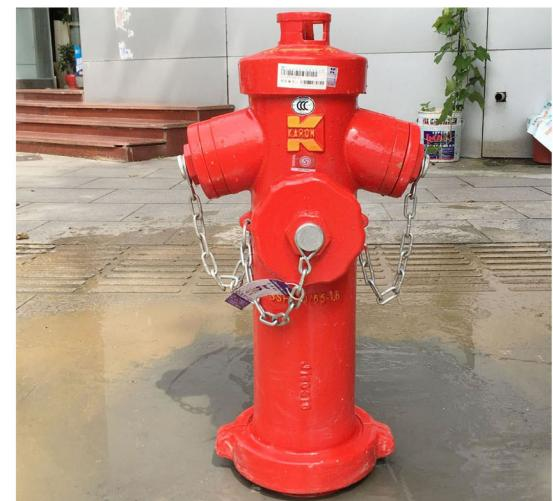
近期，澄江路两旁的消火栓全部进行了升级换代，不仅形象统一，还从材质、设计、功能上进行了升级。新式消火栓内部设有的特殊装置，在受到外力撞击后会自动启动，阻止自来水喷涌而出，既不会造成水资源浪费，又避免周围设施和道路受到影响。维修也只要更换断裂环，就可快速投入使用，经济省时。
