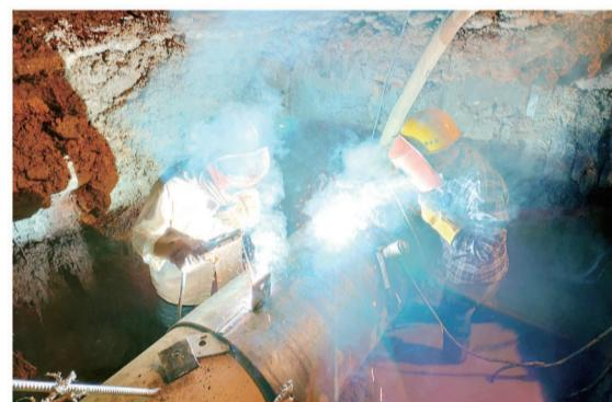
8月22日晚上9点，通江路造纸厂公交站附近DN500水泥管发生爆管。抢修人员快速响应，搭建围挡、设置路牌及爆闪灯、路面清理、抽水、制定维修方案、修复管道……直至凌晨四点，赶在用户早上用水高峰前顺利通水。
