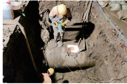
人员火热的心。管道刚开孔，抢修班长袁真华就一马当先钻入其中，切割打磨破损处，空中到处飘散着玻璃纤维颗粒。幸好班组早有准备，提前穿戴好了口罩、眼镜及防护服，内外共同协作，克服重重困难，提前完成修复。能打硬仗、能打胜仗，抢修队就是这样的一只队伍。
